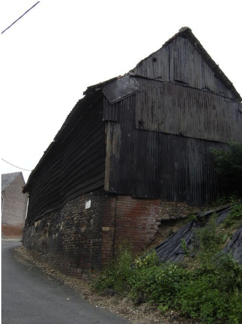
Vue des bâtiments situés le long de la rue François Curé.
