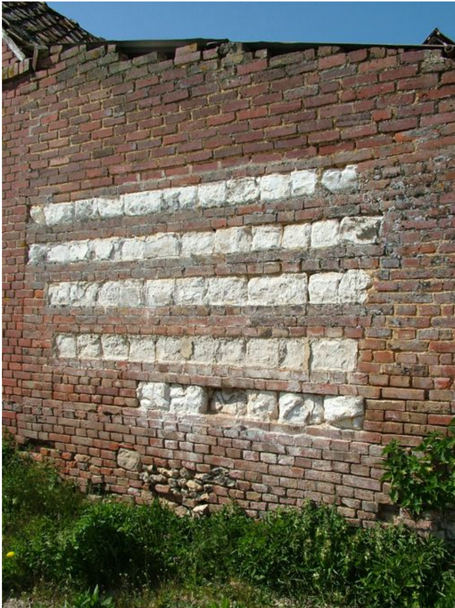
Détail de l'appareil du mur de clôture.
