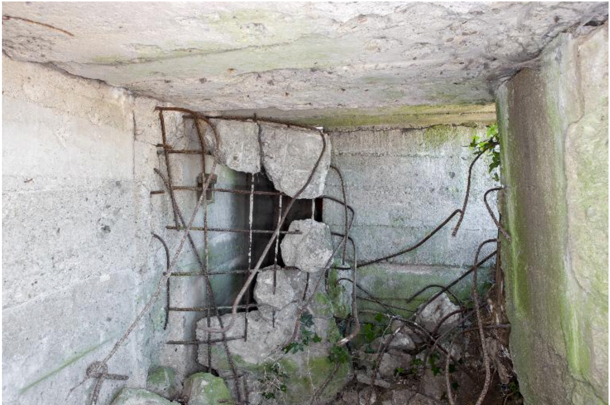
Mur en partie détruit et accès à l'observatoire bétonné
