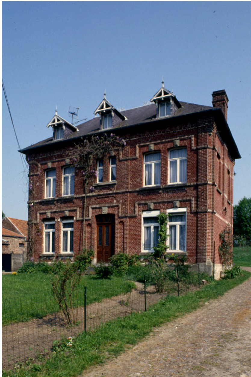
Barzy-en-Thiérache, ferme (repérée), 4 rue du Sart : logis construit en 1894.
