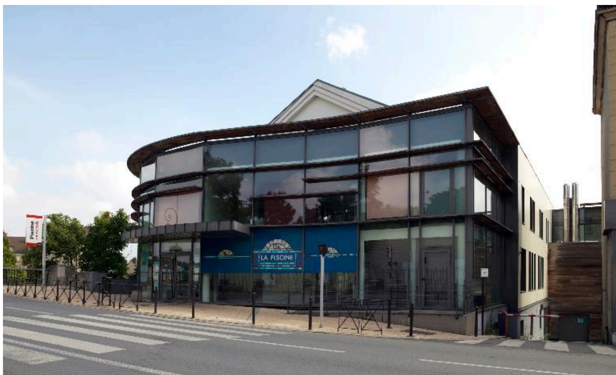
Façade d'entrée (sur rue), aujourd'hui entièrement vitrée.
