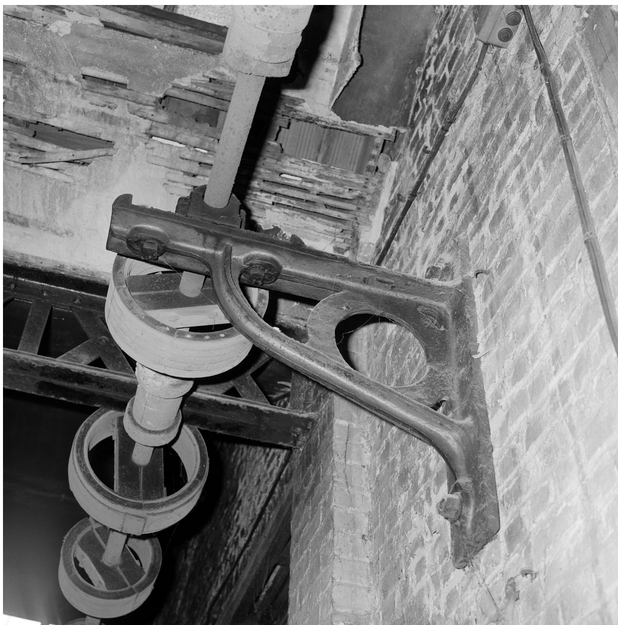
Axe de transmission, détail.
