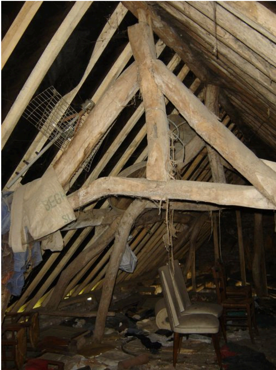
Vue d'une ferme de la charpente du logis.
