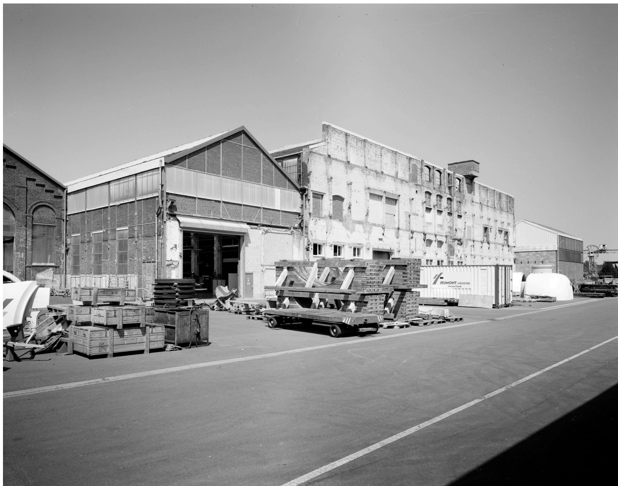
Élévation sud de la halle 1 et mur gouttereau de deux halles détruites en 1998, derrière lequel s'élèvent les halles 20 à 24.
