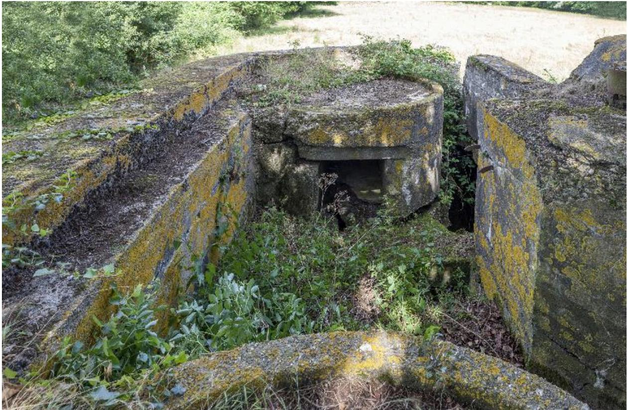
Plateforme à mitrailleuse, en face et conduit d'accès à l'intérieur de l'abris, à droite
