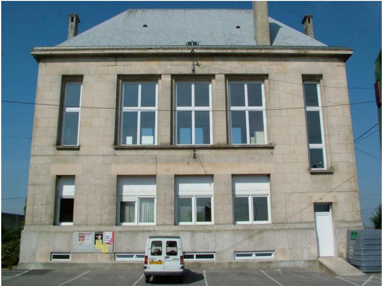
Vue arrière du bâtiment.
