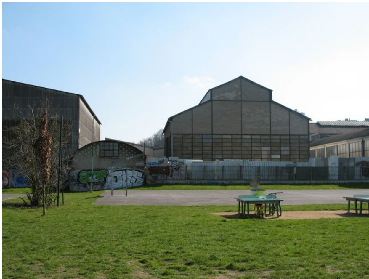
Grande halle depuis le nord.
