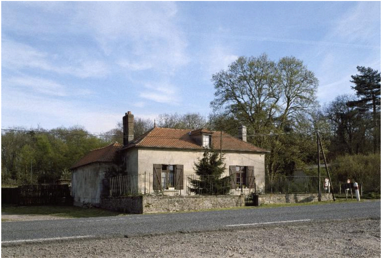
Vue de la façade donnant sur la RN 2.
