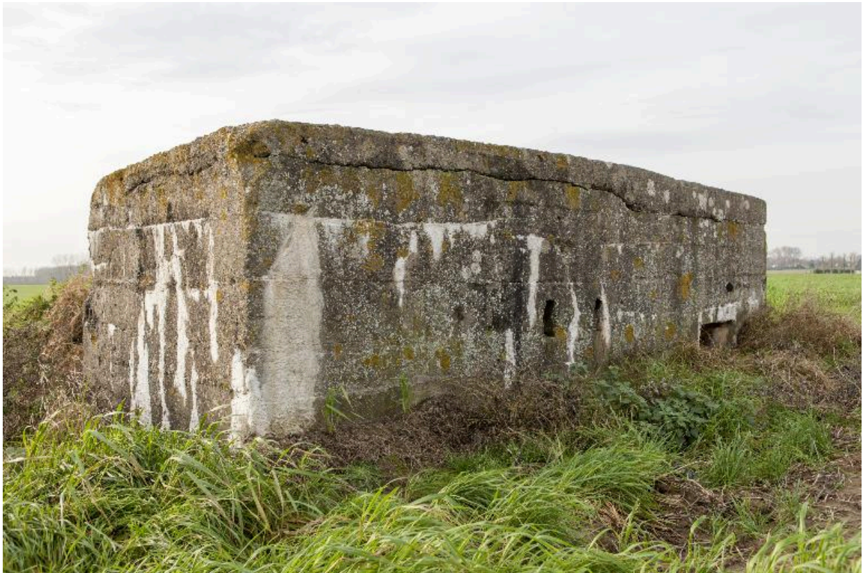
Vue de trois-quarts arrière, vers l'ouest
