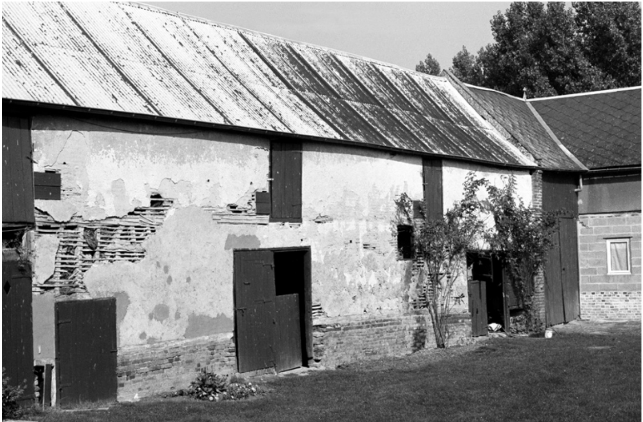
Vue des étables en torchis fermant le côté nord-ouest de la cour.
