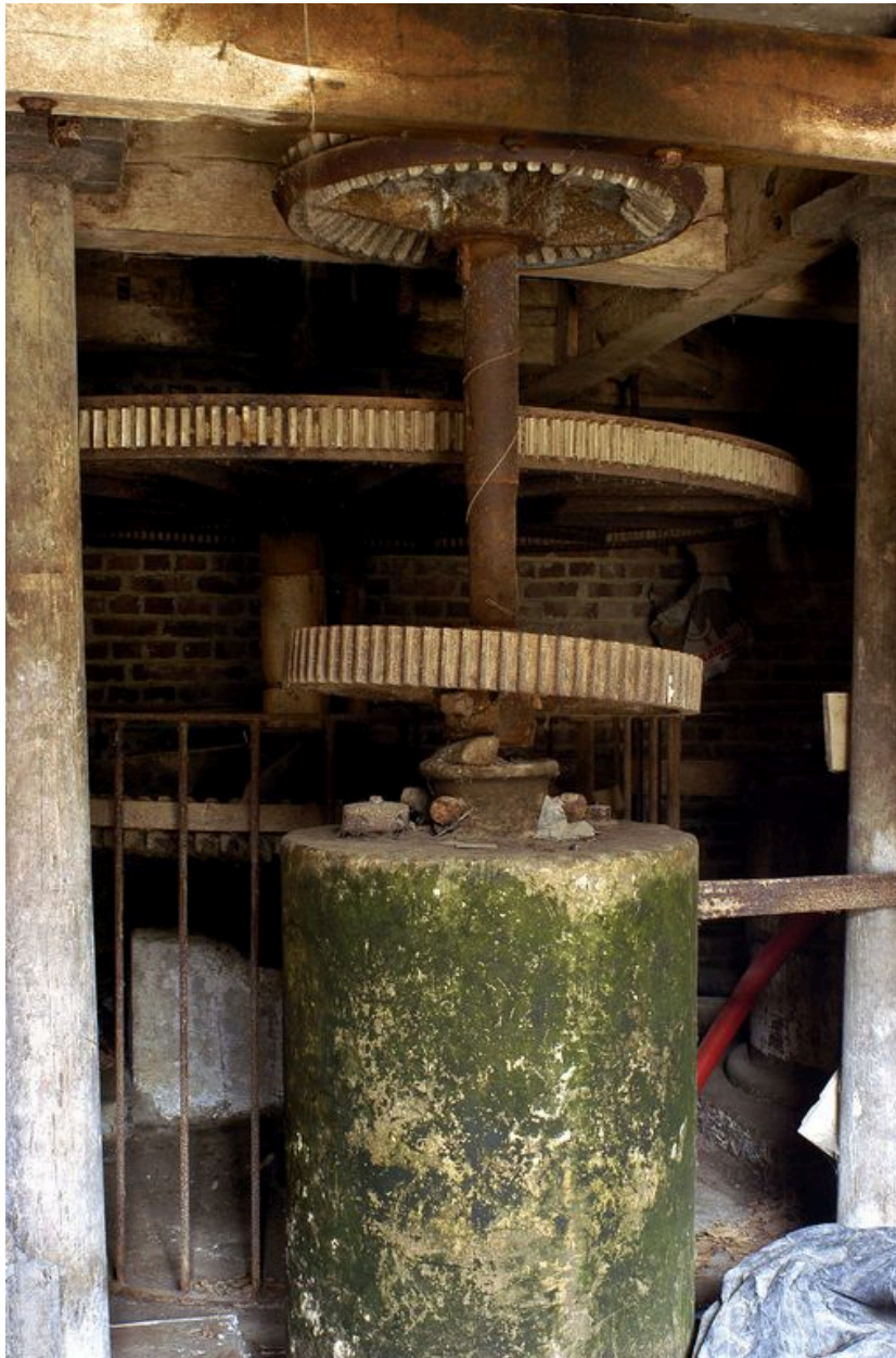
Détail des engrenages de transmission vers l'une des meules du premier étage.
