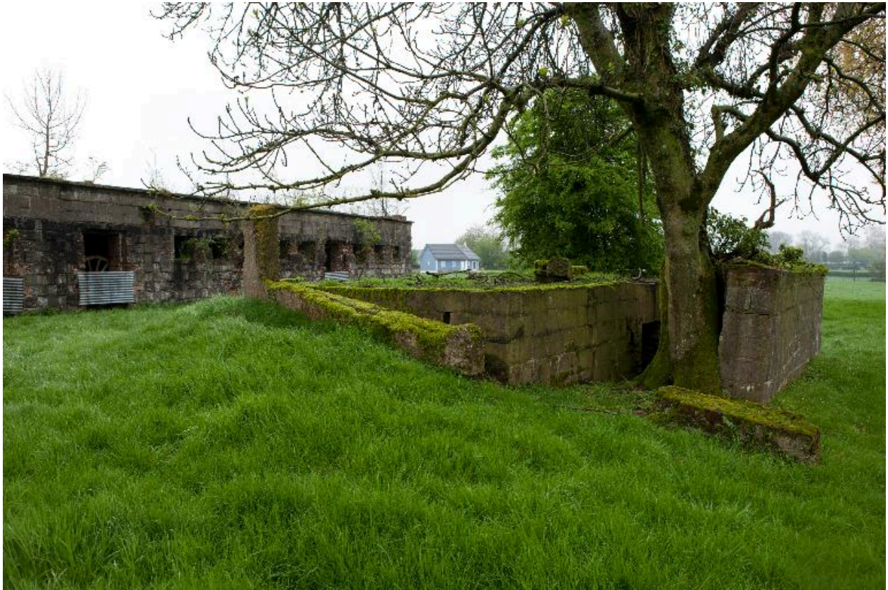
Bâtiment de stockage des réactifs chimiques. A l'arrière-plan, le bâtiment de montage.
