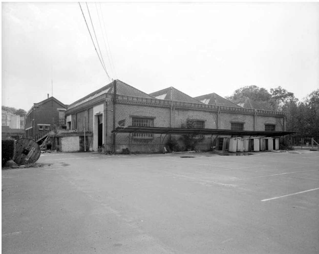
Atelier de fabrication, flanc nord-ouest.
