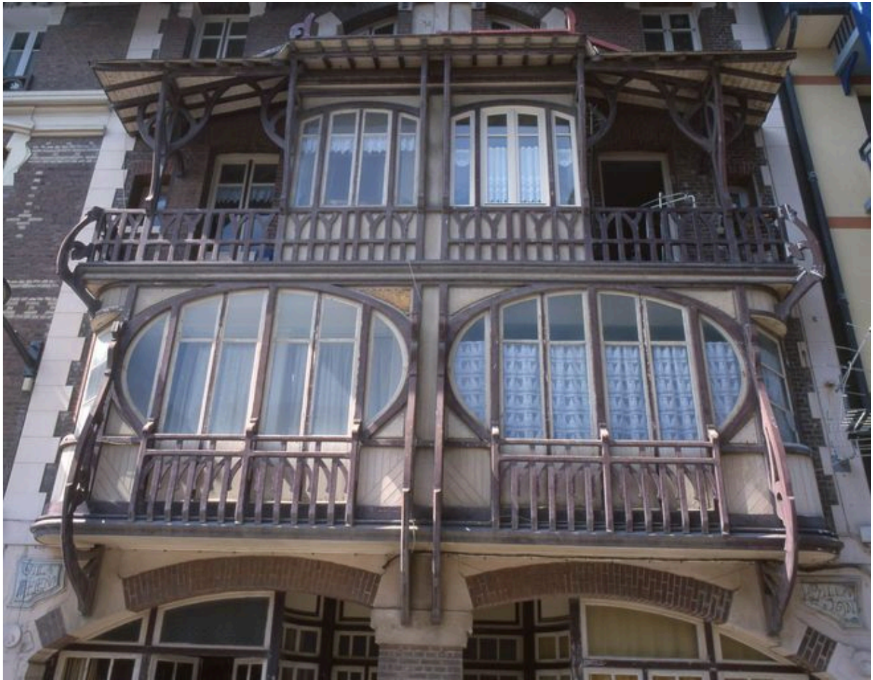
Détail du bow-window du premier étage.
