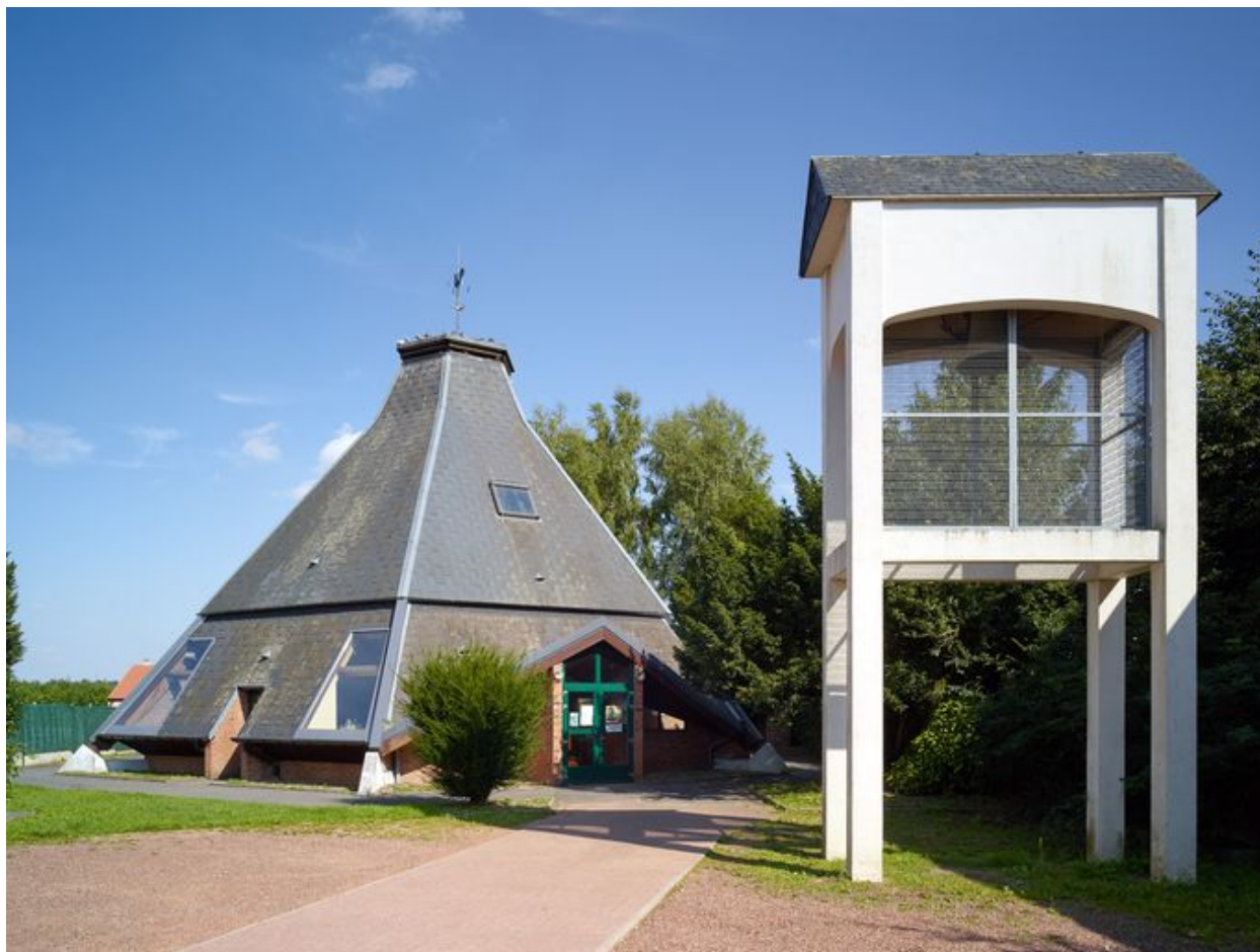
Élévation principale de l'église sud ouest , avec le clocher sur le parvis.
