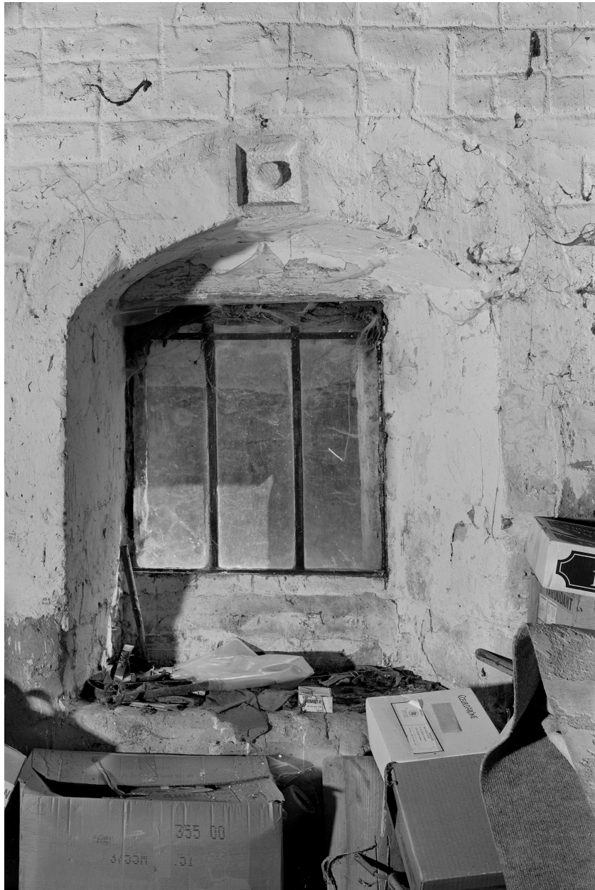
Fenêtre du rez-de-chaussée : vue de l'intérieur.
