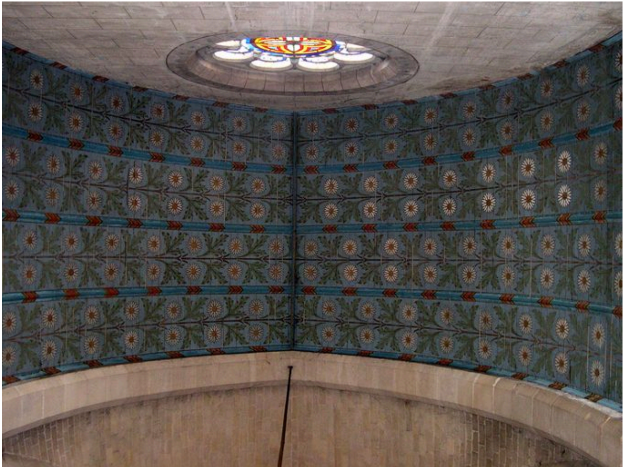
Vue du lambris de couverture du transept nord.
