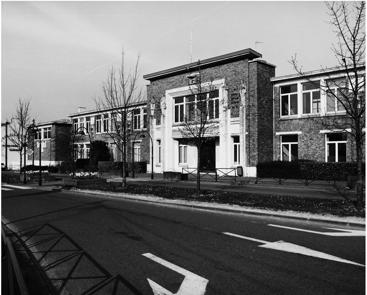
Vue partielle de l'élévation antérieure. L'entrée.
