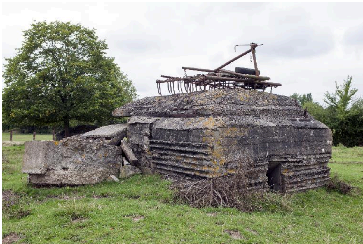
La casemate en 2015, vers l'est
