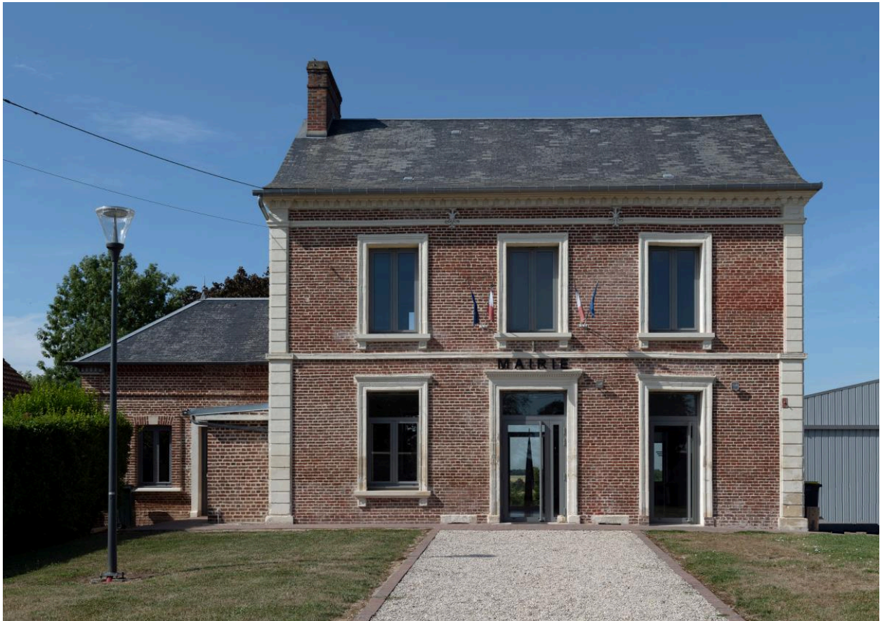
Mairie (ancien presbytère), vue depuis le nord-ouest.
