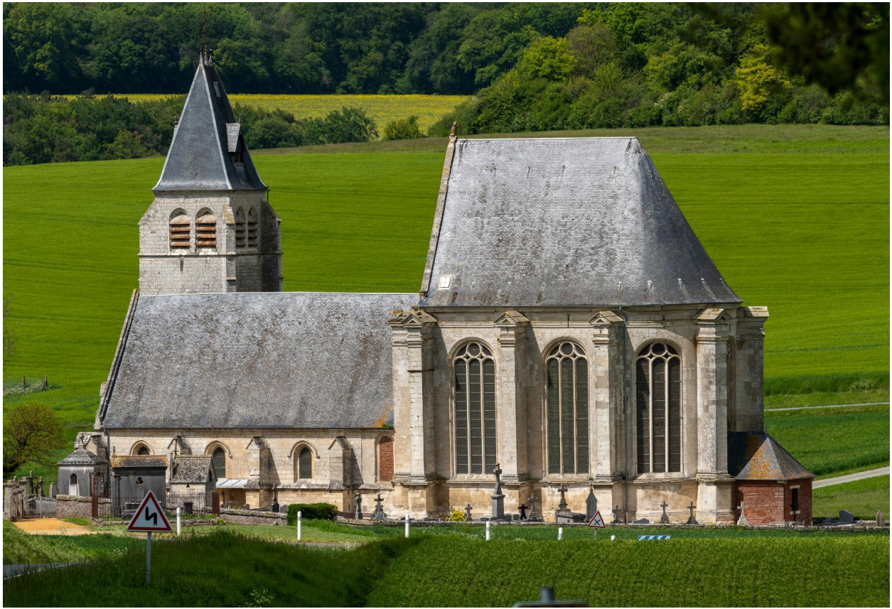
Vue générale de l'élévation sud depuis l'entrée de Bois Renault.
