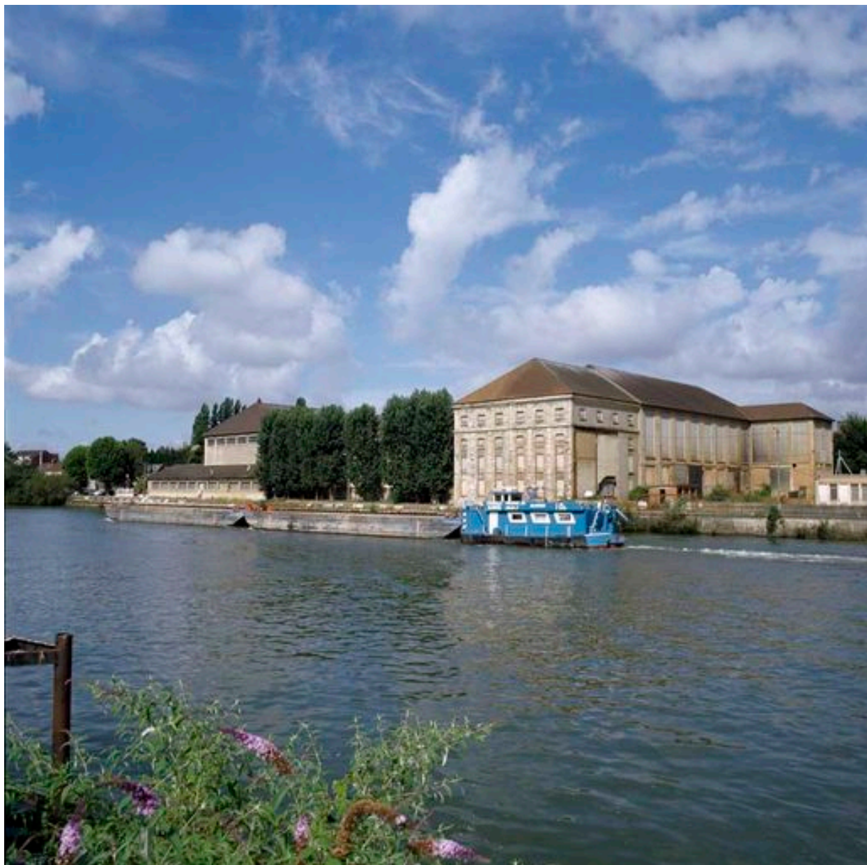
Les bâtiments de l'ancienne sucrerie.
