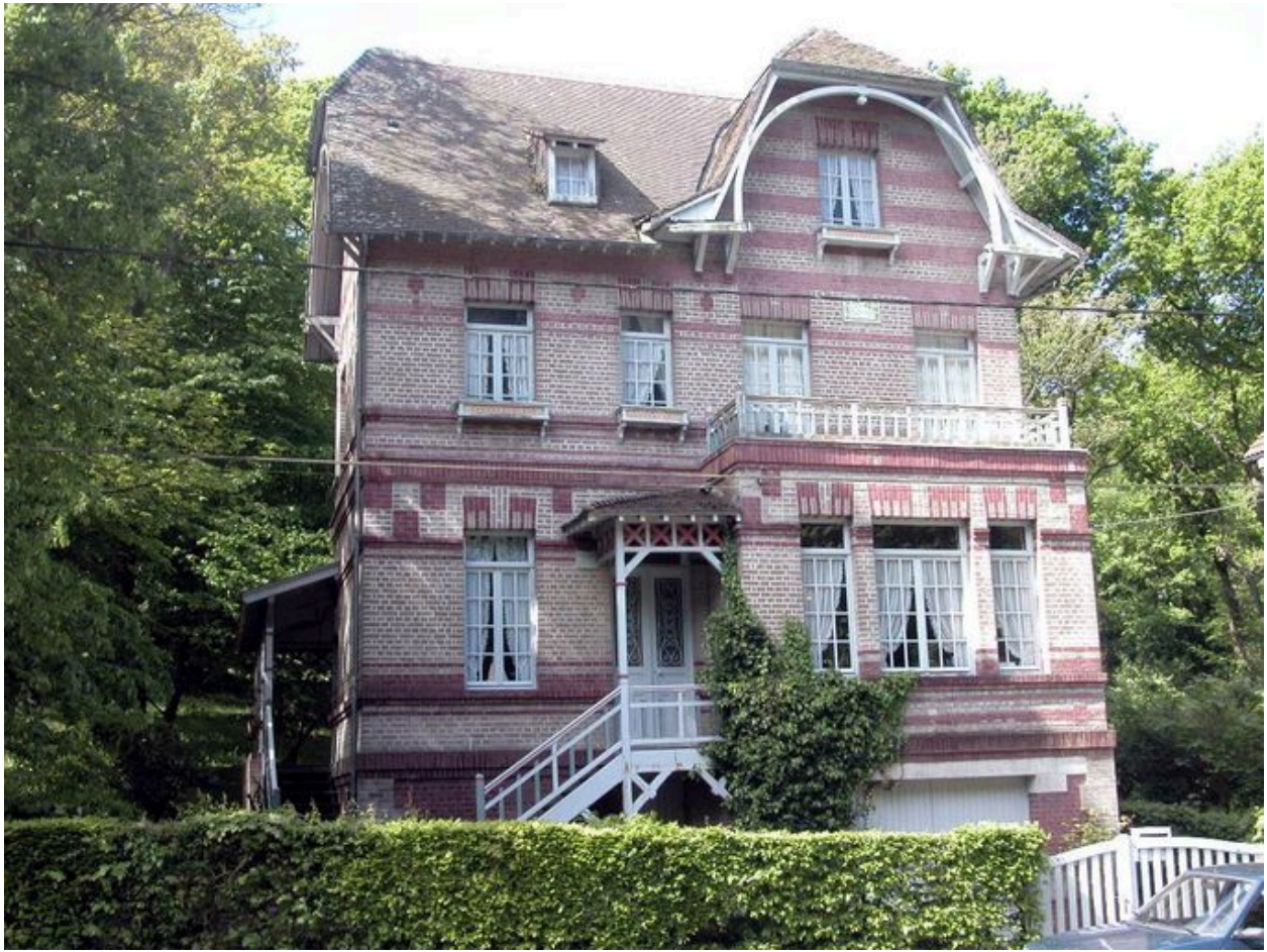
Vue d'ensemble depuis l'avenue.
