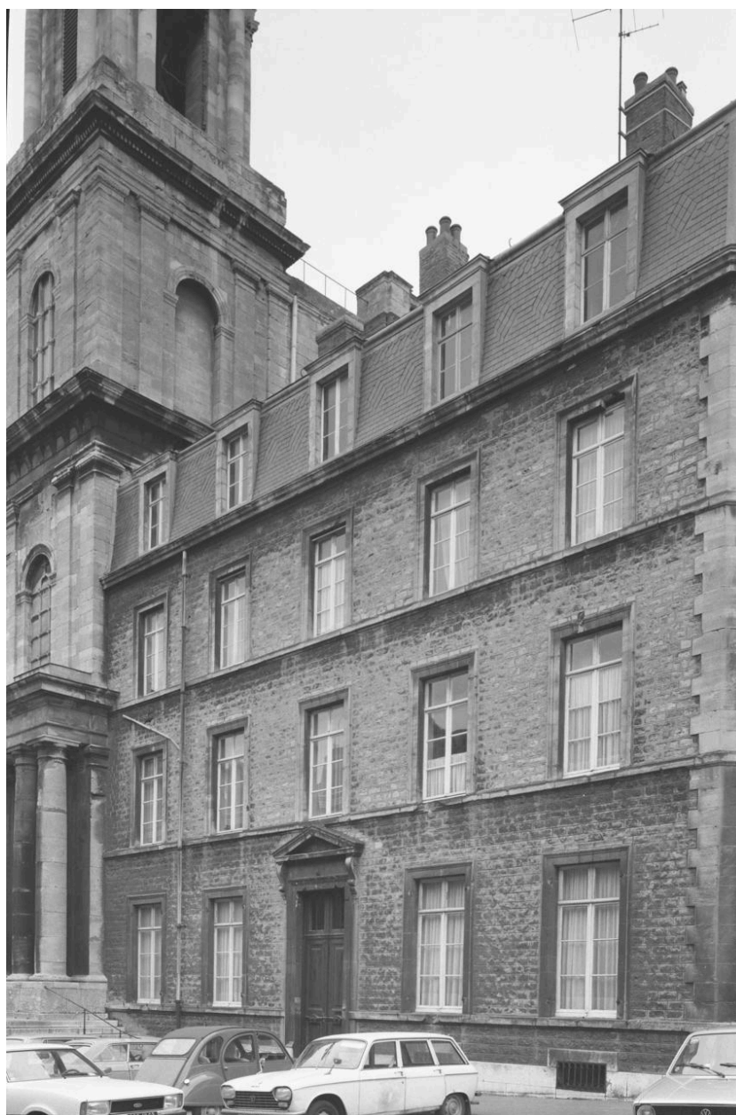
Presbytère. Façade sur parvis.
