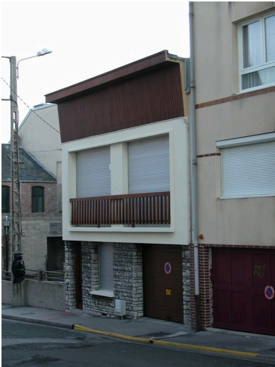
Maison, rue Maurice-Dupont (1982 AE 686).
