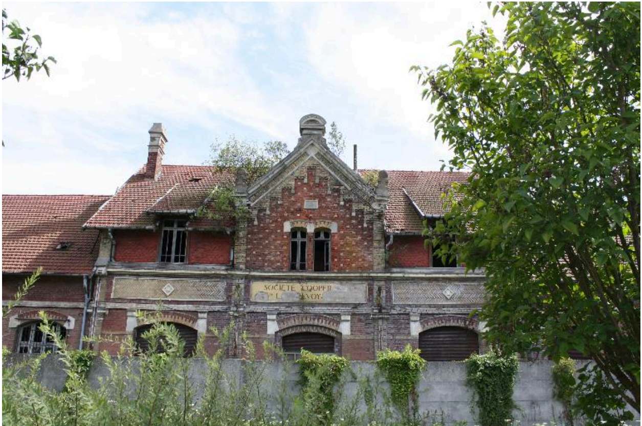
Vue partielle de la façade principale.
