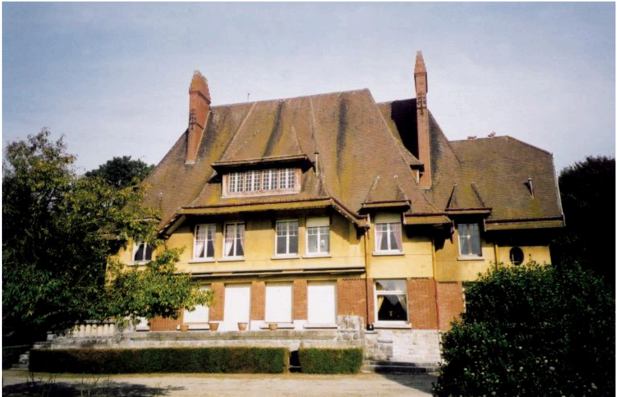
Façade postérieure sud.
