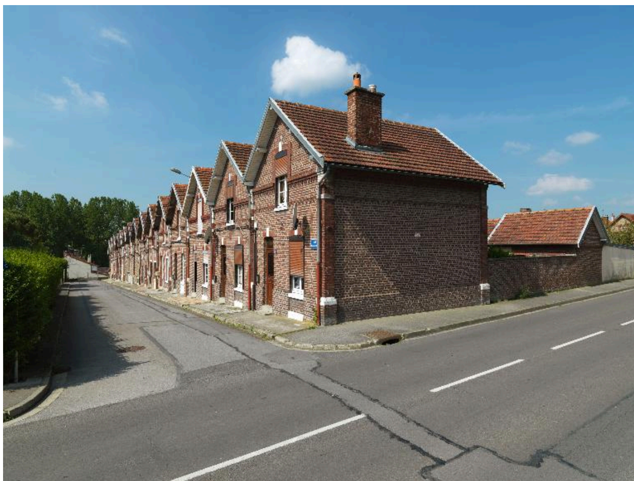
Vue d'ensemble de la cité Hugo
