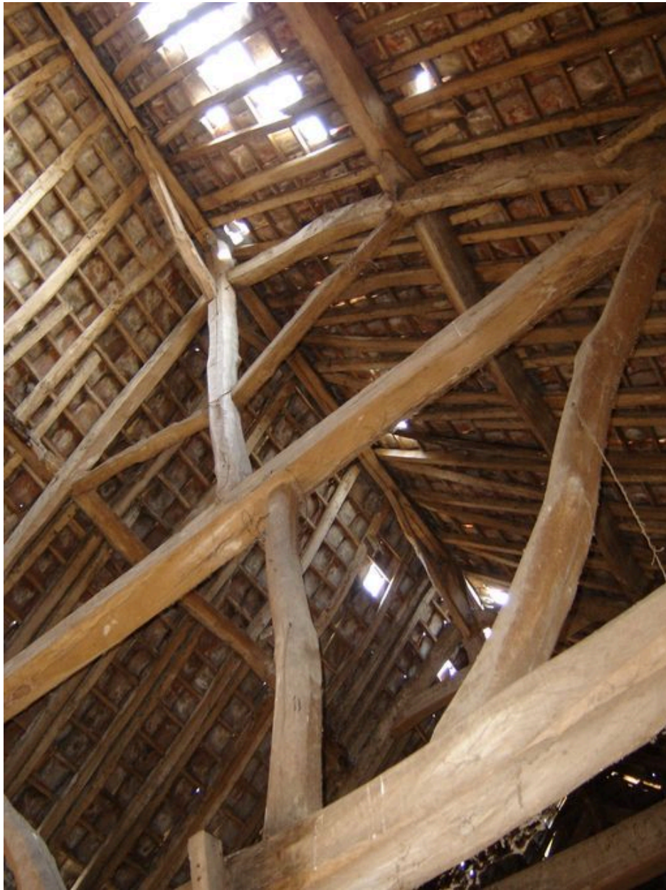
Vue détaillée d'une ferme de charpente d'une des deux granges.
