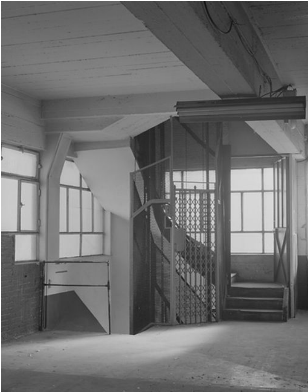
Vue d'ensemble de la cage d'ascenseur.
