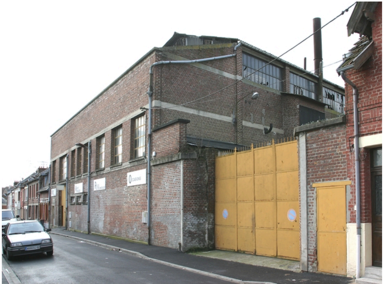
La centrale thermique vue depuis la rue Dornenberger.
