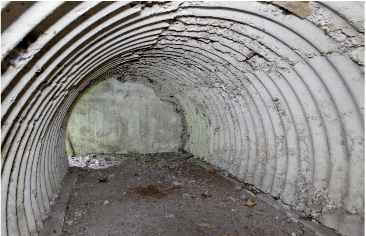
Casemate c) : Vue intérieure
