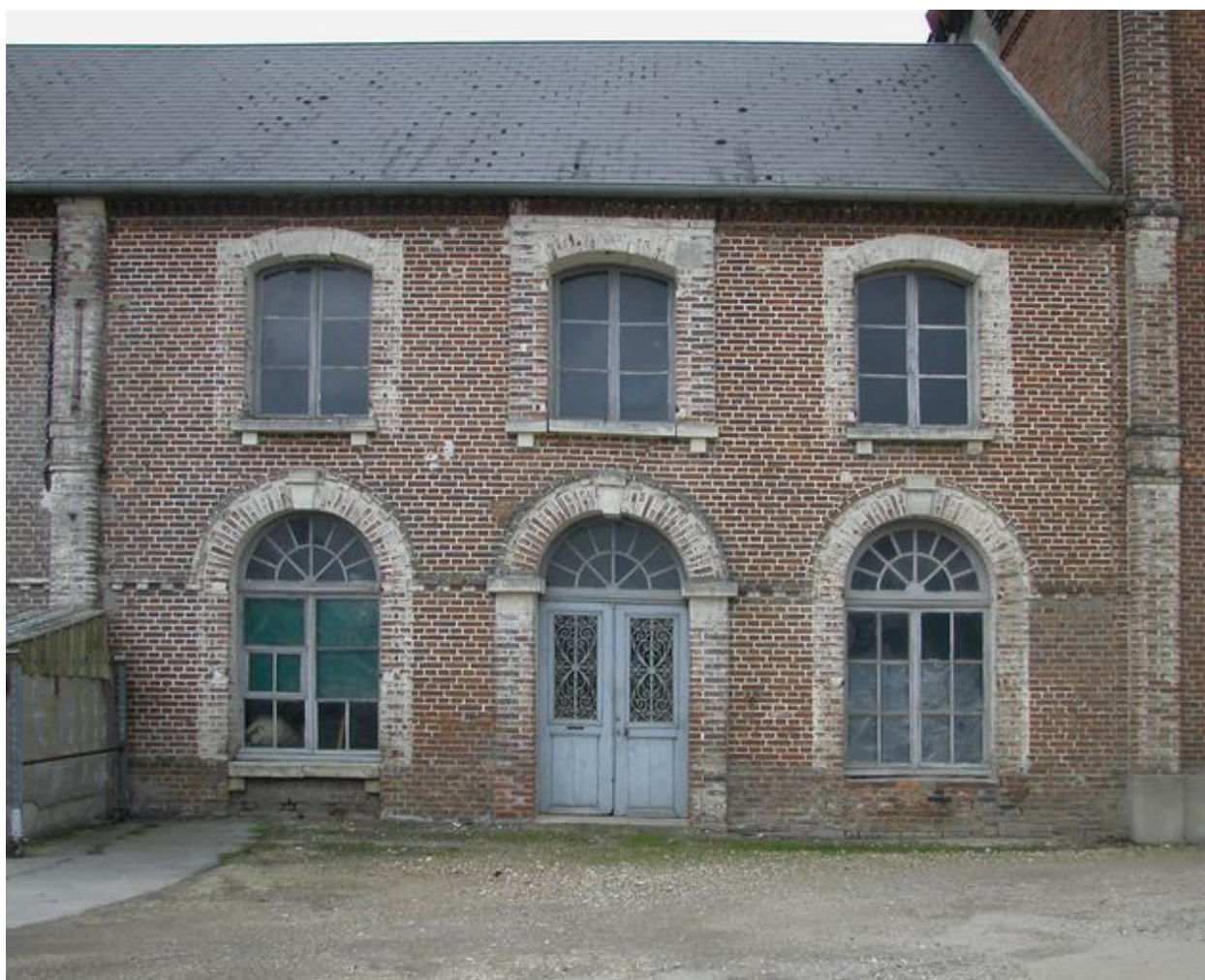
Façade sur cour, vue partielle.
