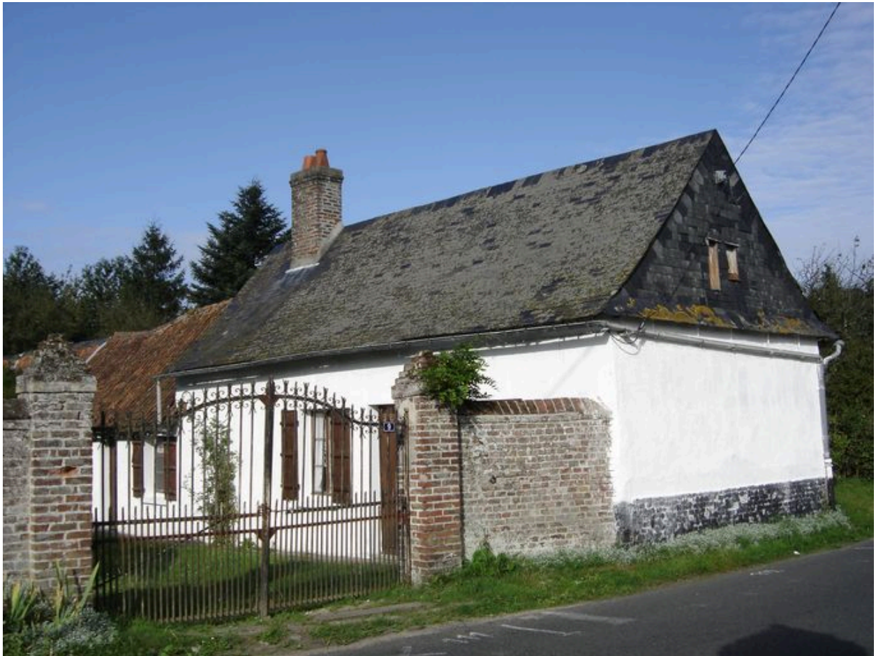
Vue du logis sur rue.
