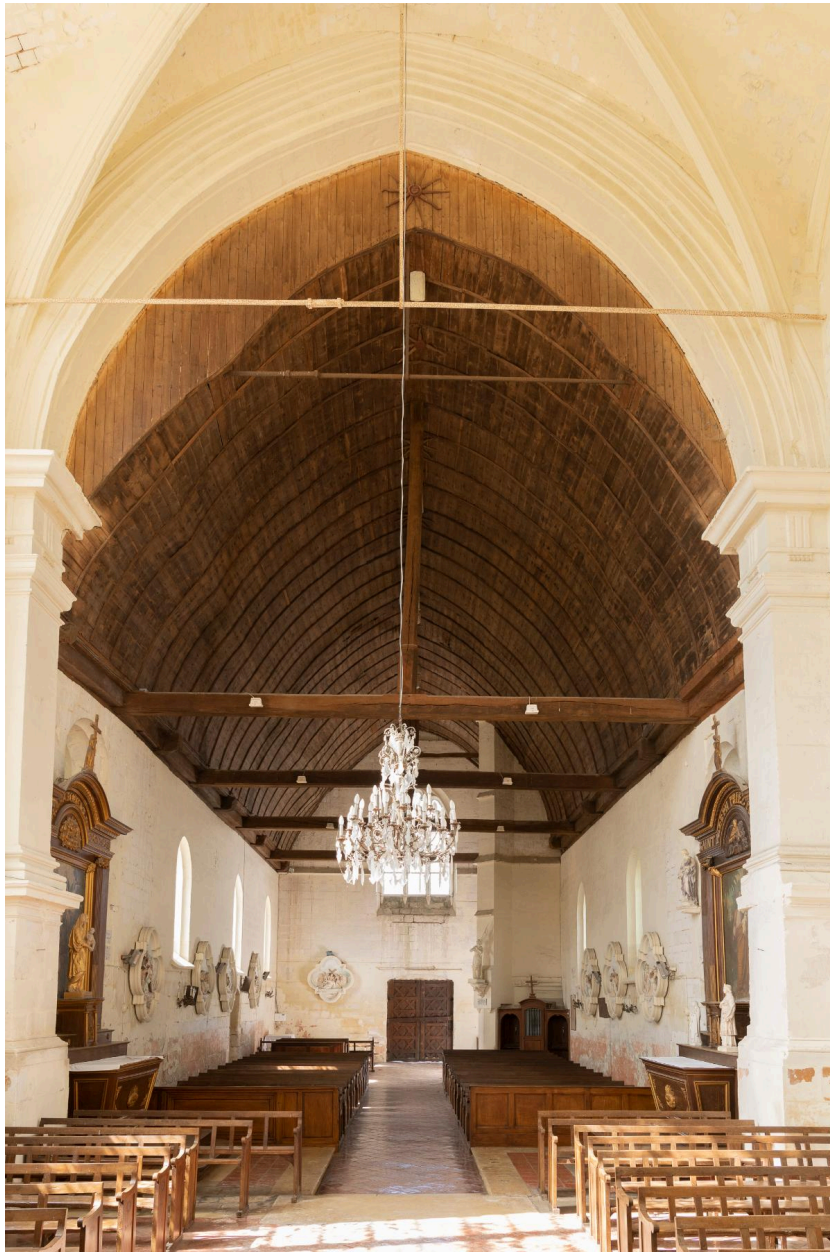
Vue intérieure vers la nef.
