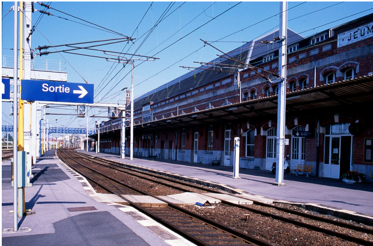
Vue générale de l'élévation postérieure (nord).
