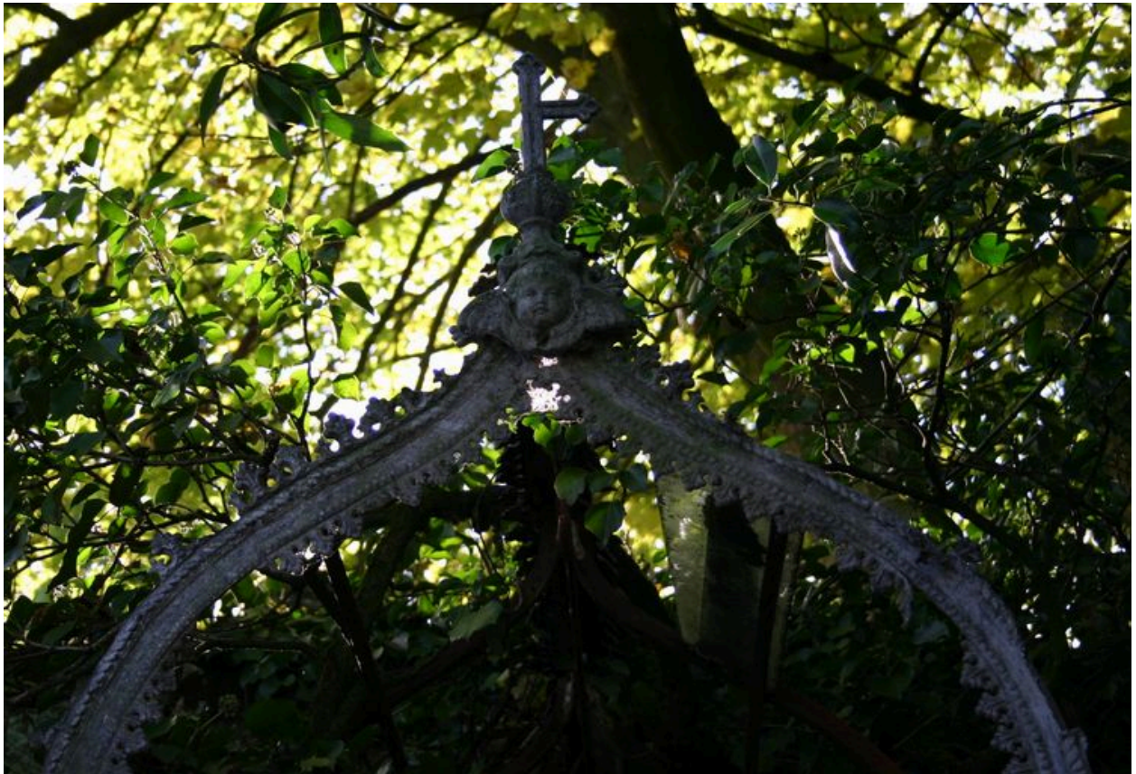
Détail de la partie supérieure du auvent-verrière (moulures en zinc et décor).
