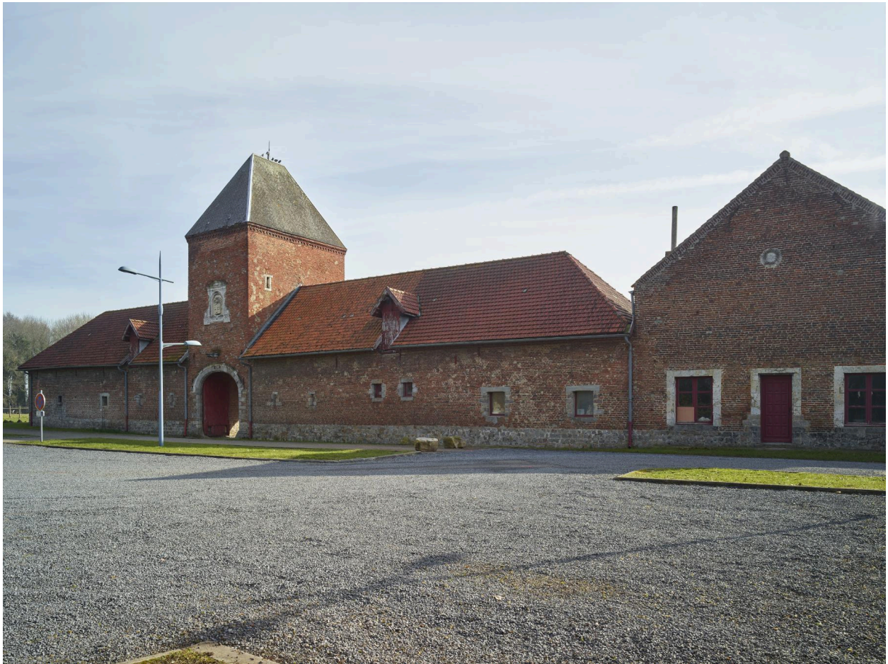
Vue générale de la façade depuis la rue.
