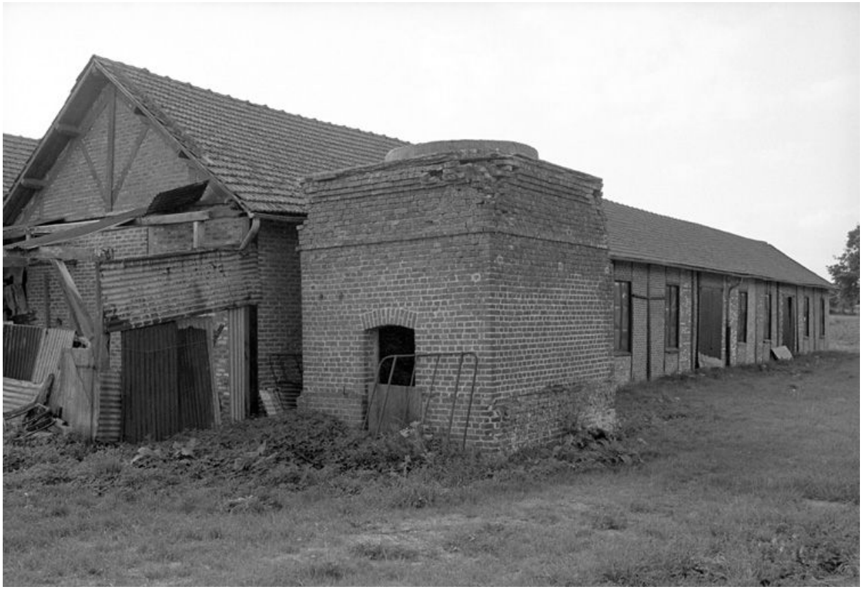
Atelier de battage, flanc ouest.
