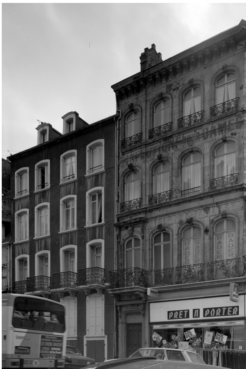
Immeuble, façade sur Grande Rue.
