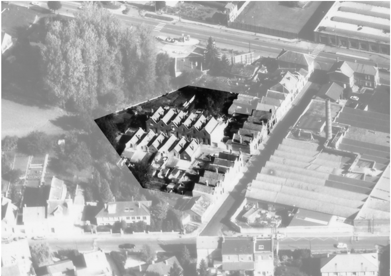
Vue aérienne de la cité en 1989.
