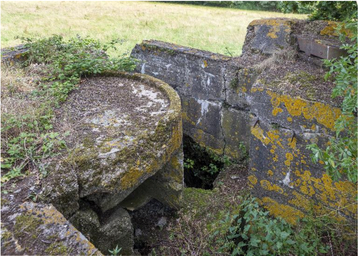
Plateforme nord-est et observatoire casematé
