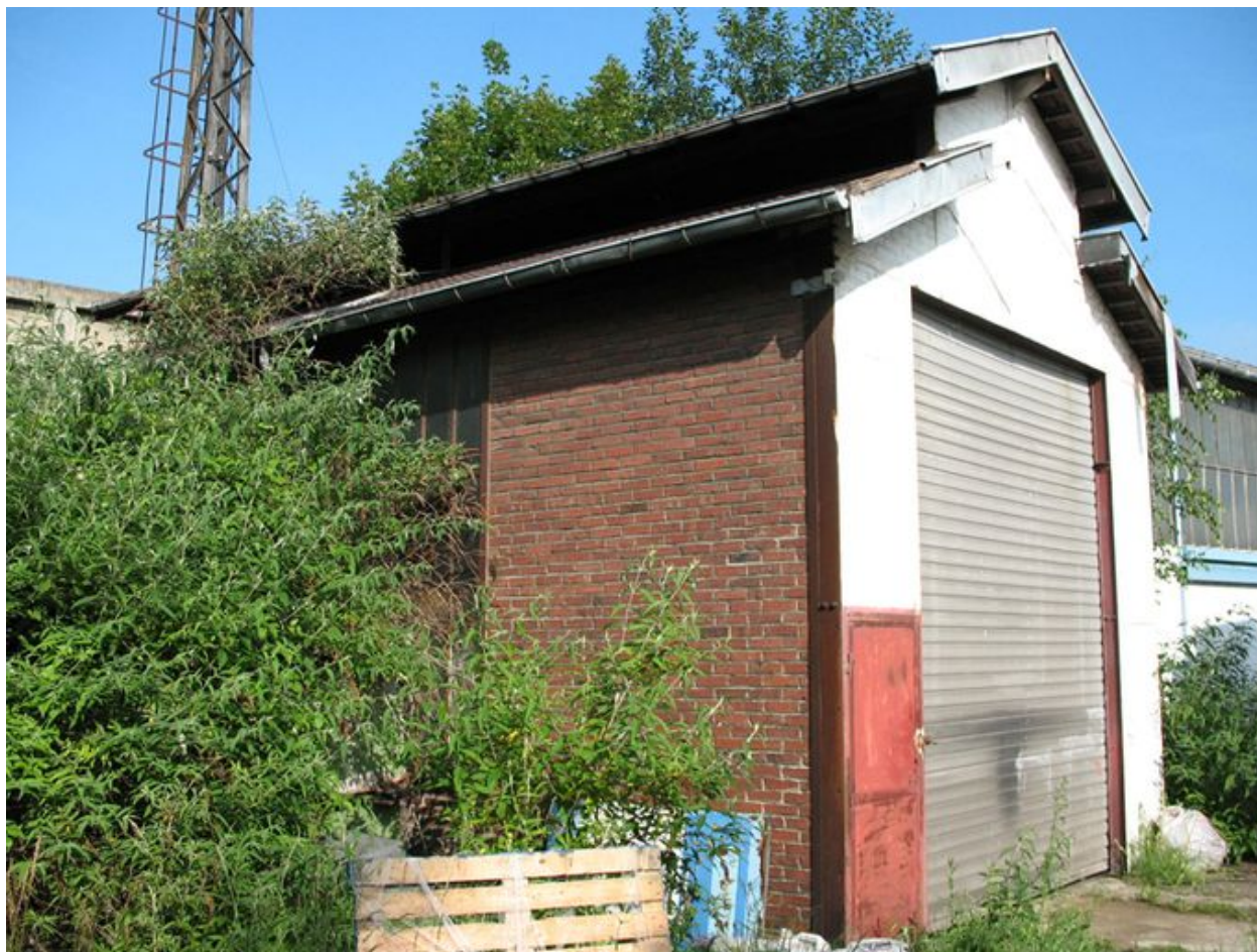
Remise à locomotives.
