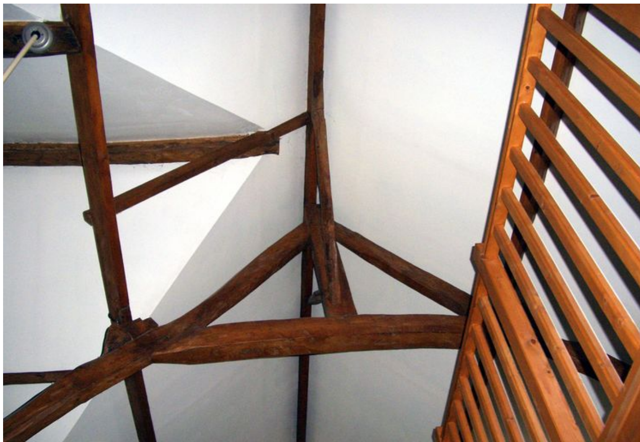
Vue de la charpente de l'ancienne grange.
