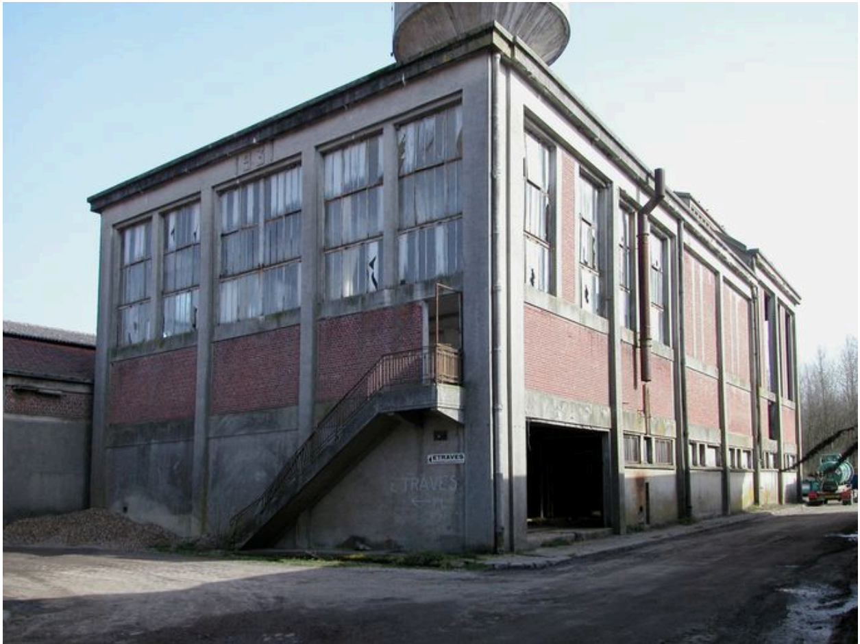
La chaufferie de 1931, vue d'ensemble.
