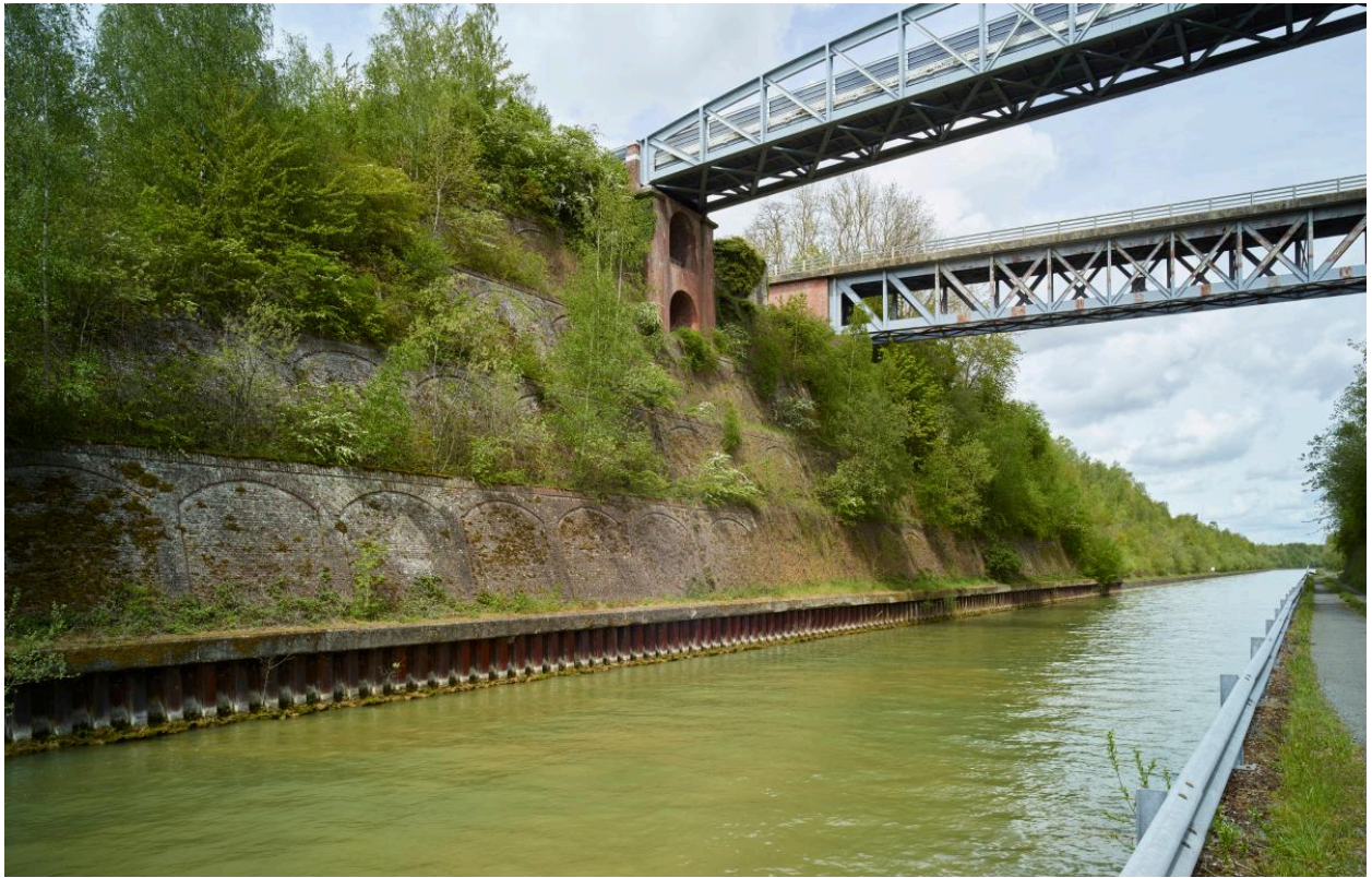
Vue depuis le sud. Murs de soutènement en gradins, deux ponts.
